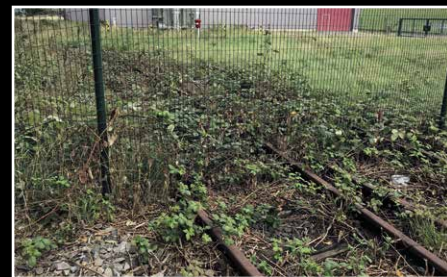
Offensichtlich ungenutzt: Der landseitige Gleisanschluss des Eisenbahn-Deichschart.
