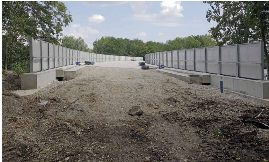
Diese Brücke bei Unterföhring endete vorn und hinten im Nichts. Jetzt wird sie für Fuchs und Hase umgebaut.
