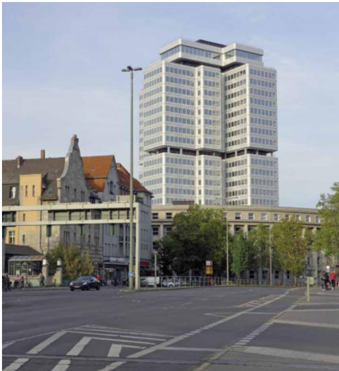
Der Campus Hohenzollerndamm der Deutschen Rentenversicherung Bund wird Jahre später fertig als geplant und kostet 45 Mio. Euro mehr.
