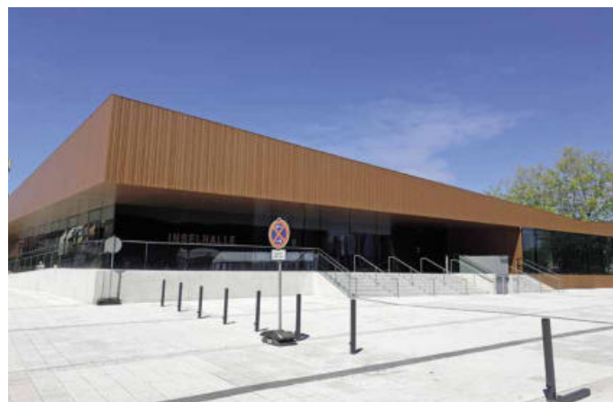
Die Ausgaben für die Sanierung und Erweiterung der Inselhalle in Lindau stiegen von 35 auf 45,4 Mio. Euro.
